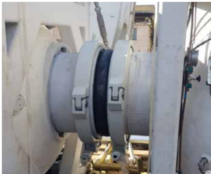
Фото 7. Монтажный комплекс стыковки.
