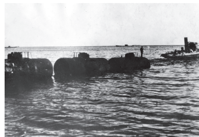
Рис. 5. Прокладка первого подводного трубопровода на Ладоге в 1942 году
